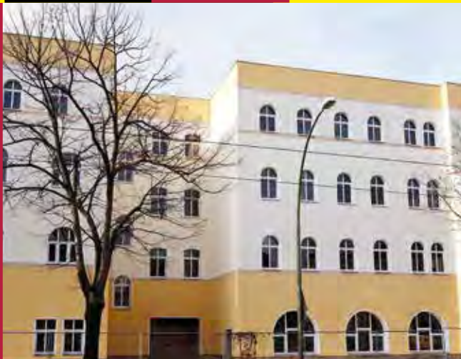
WDVS mit EPS-Dämmplatte und dickschichtigem, mineralischem Putzaufbau
