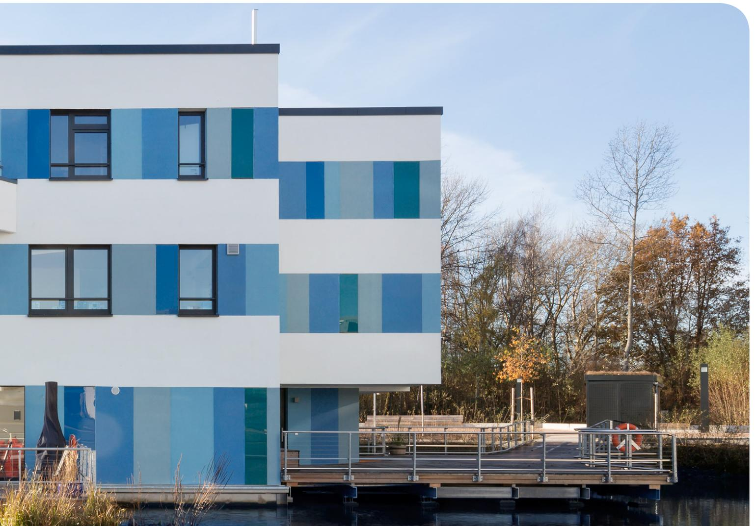
Durch die Verklebung sind keine sichtbaren Befestigungsmittel wie Schrauben oder Rahmen notwendig. Das System lädt dazu ein, mit großen Flächen zu spielen, denn die mit **weber.therm style** gestaltete Fassade ist fugenarm.
