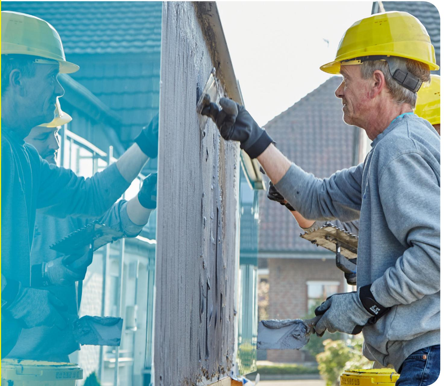
**Im Vergleich mit einem vorgehängten System ist eine WDV-Fassade wärmebrückenarm.**
